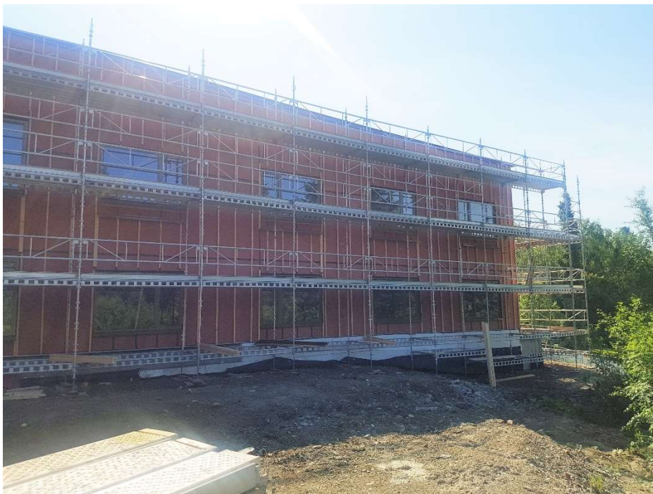
Figur 3: Oversikt utvendig fasade
